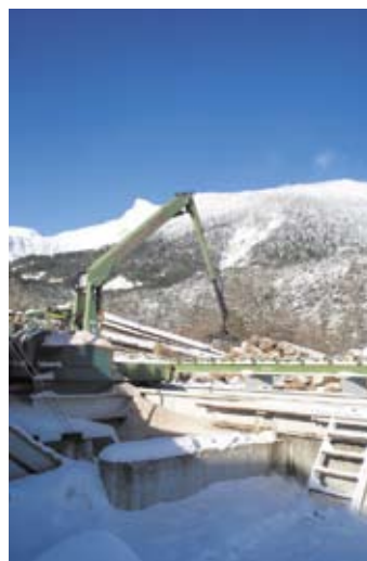
Accès au chariot à grumes par des marches
