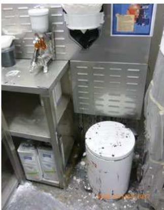
Photo 5 Captage enveloppant au niveau d'une machine de lavage des pistolets
